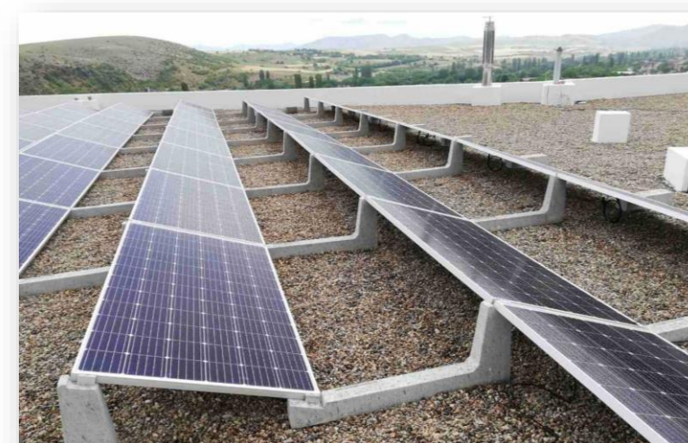
Panneaux lestés en toiture
